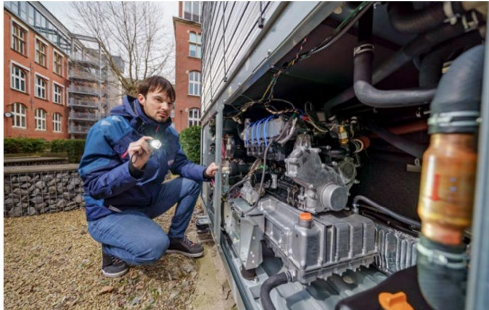
Richie Zubek vom Technischen Dienst präsentiert die Gasmotorwärmepumpe. Sie kombiniert die derzeit effizientesten Energietechniken in einem Gerät und sorgt für ein gutes Klima im Studierendenzentrum.
